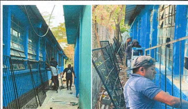
Foto 2: Mejoramiento y Colocación de balcones para aulas seguras.
